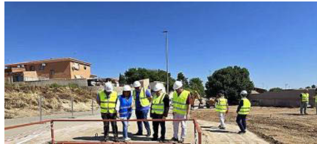
Muro observa el inicio de las obras, ayer en Cobisa.
