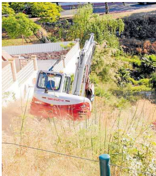
Maquinaria trabajando en la reparación de la tubería. SUR
